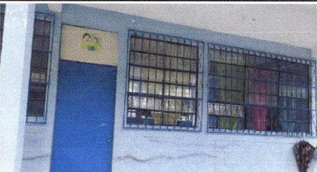
Foto 3: mantenimiento a estructura de metal
