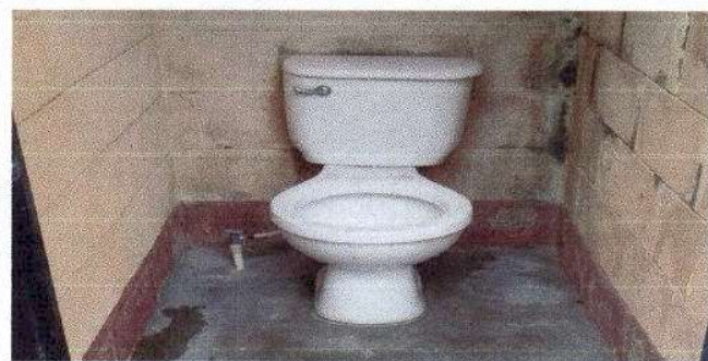
Foto 5: Sustitucion de inodoros
