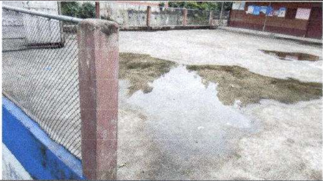
Foto 1: Impermeabilización de losa
