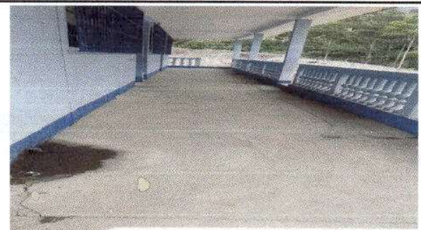
Foto 4: Sustitucion de piso ceramico
