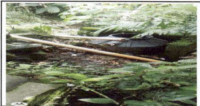
Foto 6: Sustitucion de tuberias PVC Linea principal aguas negras
