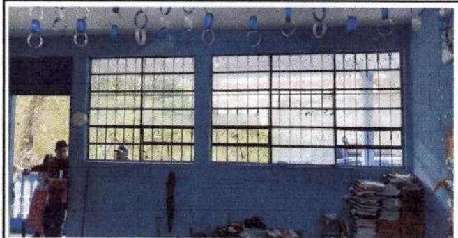
Foto 2: Sustitución de vidrios
